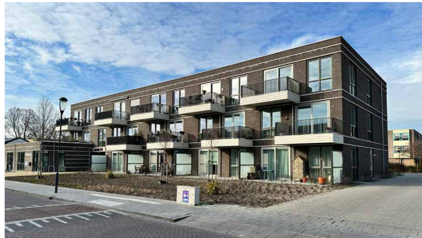
De voorzijde van woongebouw Maretak, uitkijkend op de Middenweg.
