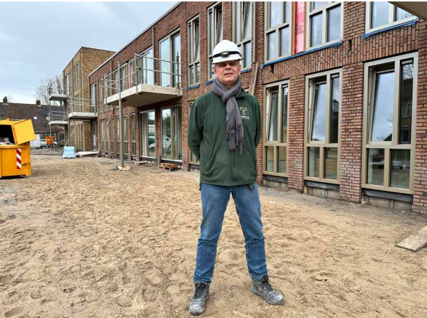
Uitvoerder Per Rinkel voor één van de appartementengebouwen, waar de steigers inmiddels grotendeels zijn weggehaald.
