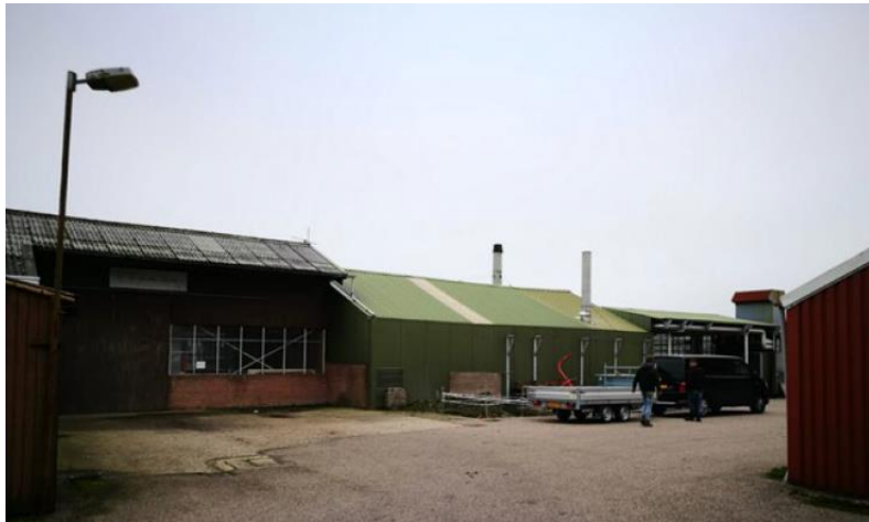
Figuur 6: Bestaande opstallen op het terrein
