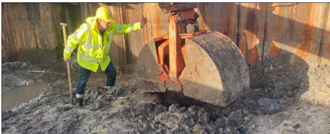
Met de knijperbak wordt de modder uit het wrak geschept.
