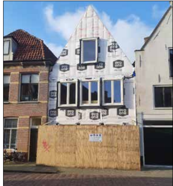
De isolatie van de voorgevel aan West 43 is op de houtskeletbouw aangebracht.
