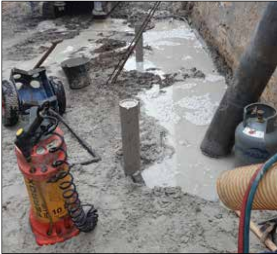
De palenboor boort de elf palen in de historische dijk.
