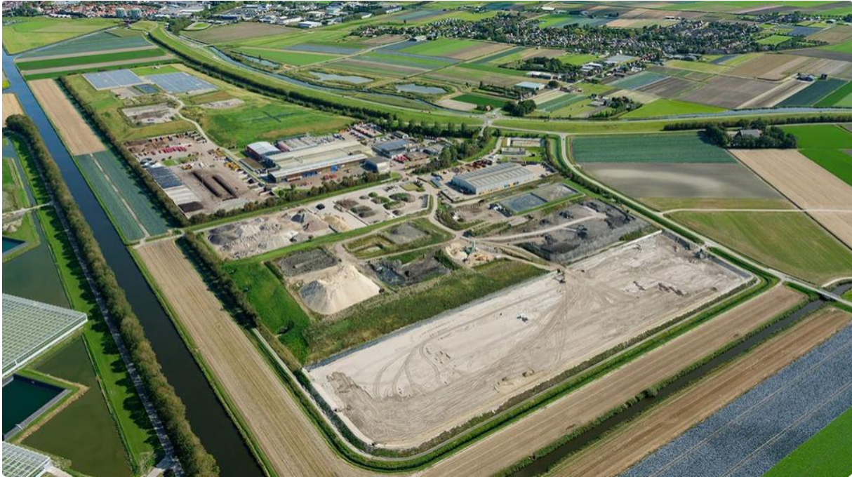
De afvalverwerkingslocatie Middenmeer
